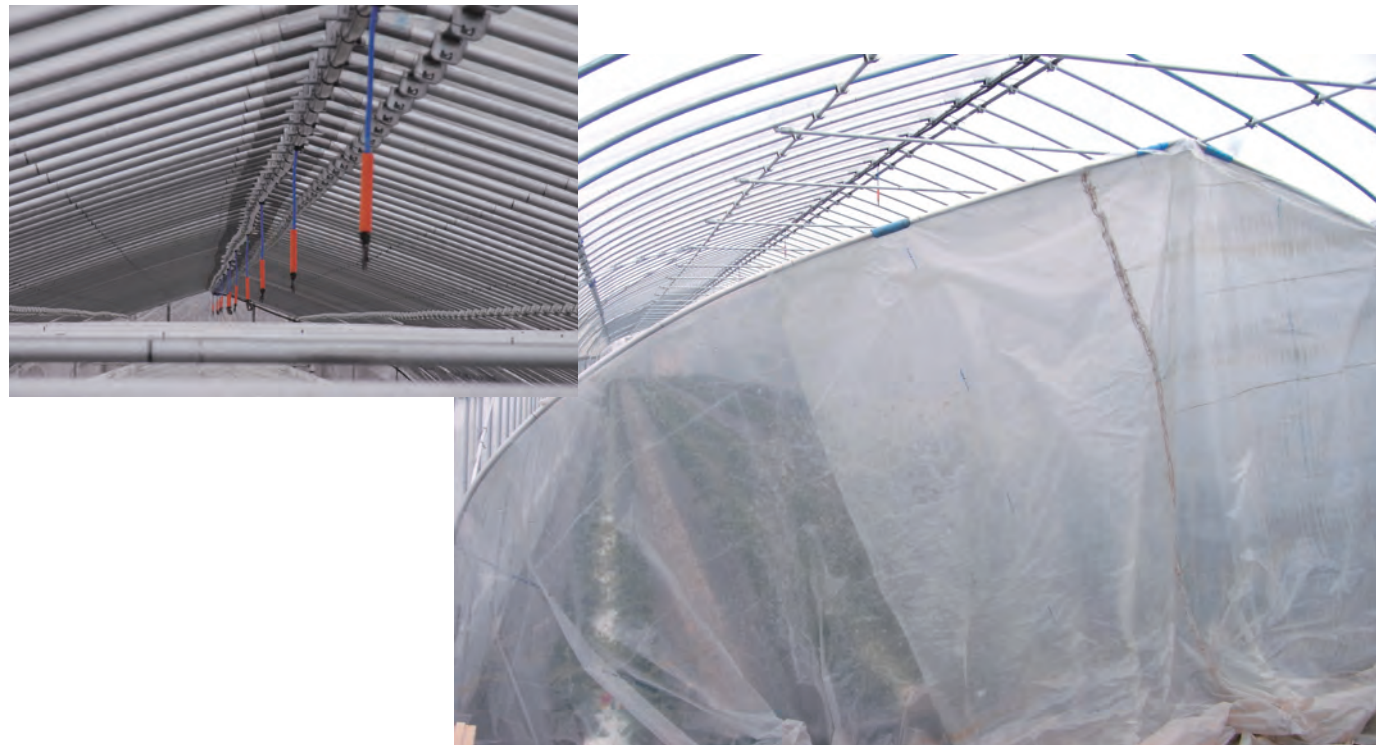
図08 ハンガースプレーセットをハウスの内張り上部に4m間隔で取付けた配管例
