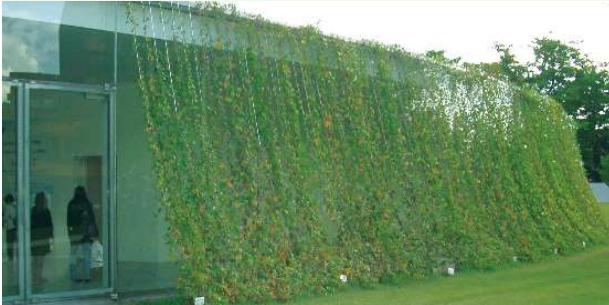
硬質ドリップチューブ使用例: グリーンウォール
