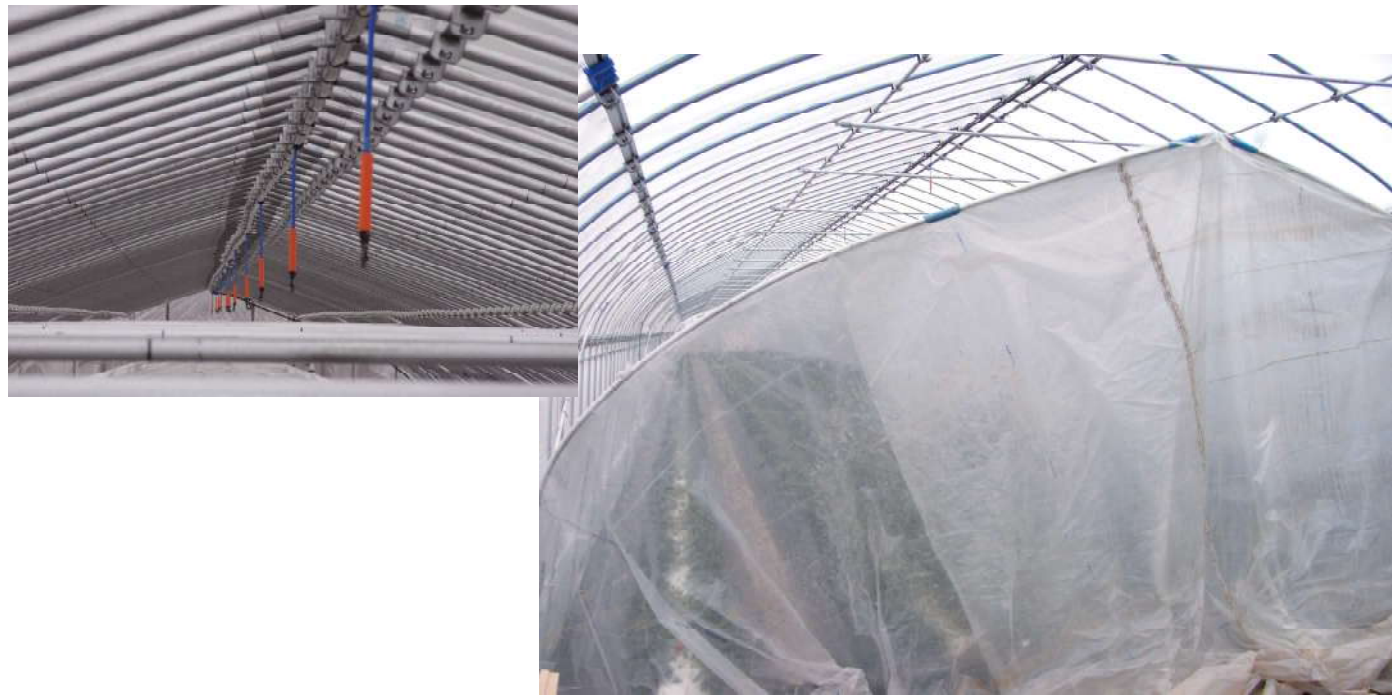
図08 ハンガースプレーセットをハウスの内張り上部に4m間隔で取付けた配管例
